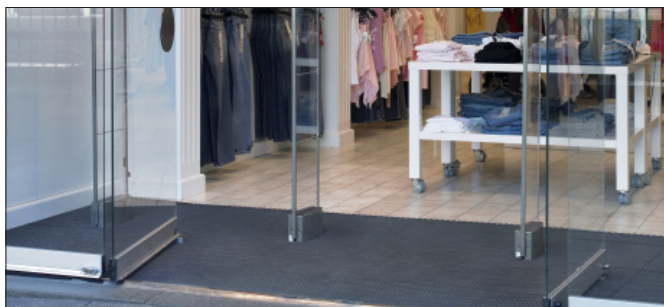
Ovansidan har en hög skrapklack. Undersidan är dränerad åt två håll.
